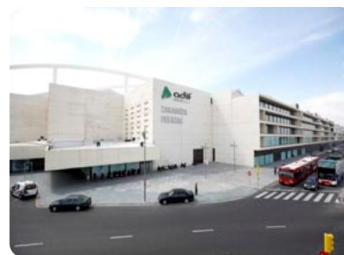
Telemando de Energía de Zaragoza
