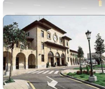
Telemando de Energía de Oviedo
